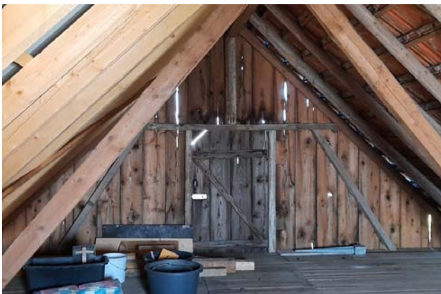
Abb. 18: Dachstuhl des Schuppengebäudes (Blick in nördliche Richtung).
