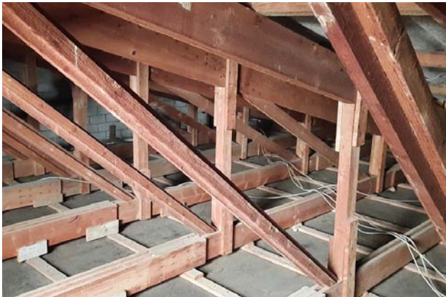
Abb. 16: Balkenstruktur im Dachboden über der Werkstatt.
