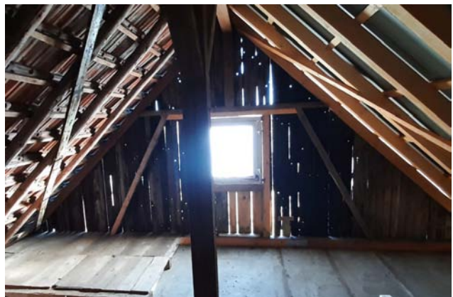
Abb. 19: Dachstuhl des Schuppengebäudes (Blick in südliche Richtung).
