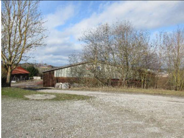
Standort: Zufahrt an der westlichen Grenze des Plangebiets; Blickrichtung: Südosten, Sicht auf ehem. Reithalle und Stall (Foto: L. Schenk, 05.02.2021)
